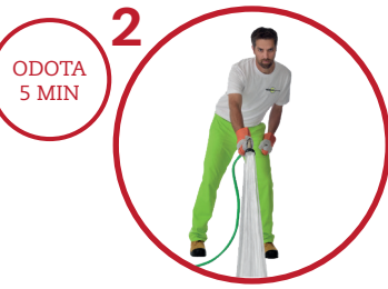
Puhdista kivetysalue suihkuttamalla
